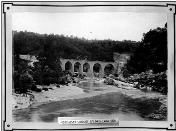
Železniški viadukt nad izlivom hudournika Avšce v Sočo julija 1905 (Vir: Album »Bohinjska železnica, zgrajena 1902–1906« s fotografijami o gradnji proge na relaciji Podbrdo–Nova Gorica; lastnik Gerhard Putz)
